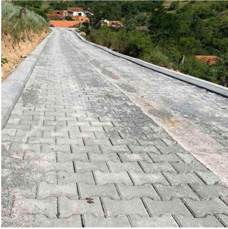
Rregullimi i rrugëve me kubëza betoni në Janjevë
