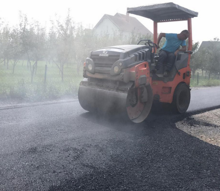
Asfaltimi i rrugicave në Bujan
