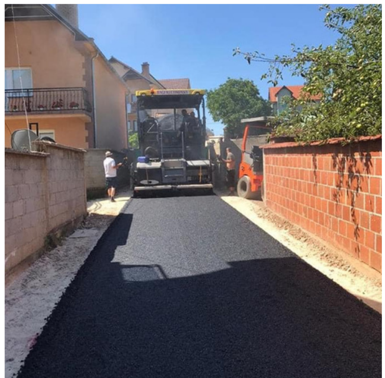
Asfaltimi i rrugicave në Gadime
