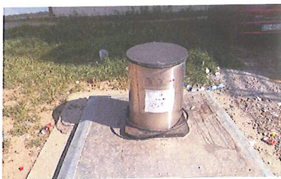
Figura 8 Kontenierët e grumbullimit kolektiv 5\text{m}^3 (nëntokësorë) dhe kontenierët kolektiv 1.1\text{m}^3
